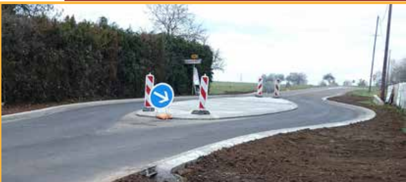
Création d'un Îlot central sortie rue de Belfort
