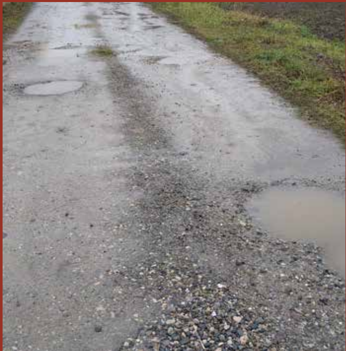
Avant réfection du chemin du Truebach
