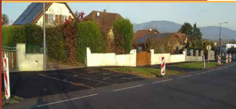
Aménagement des trottoirs et des espaces verts rue de Belfort
