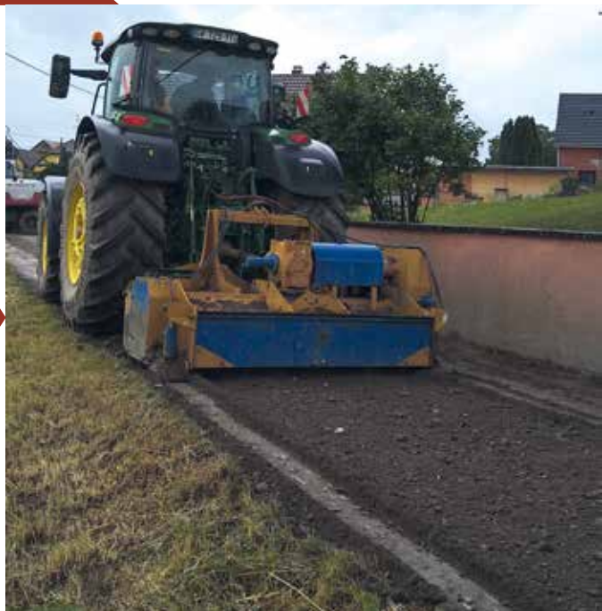
Après réfection du chemin du Truebach
